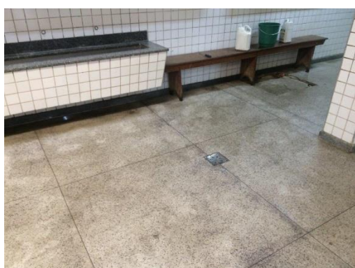
Foto nº 11 – Vista do piso do tipo granilite no pátio interno
