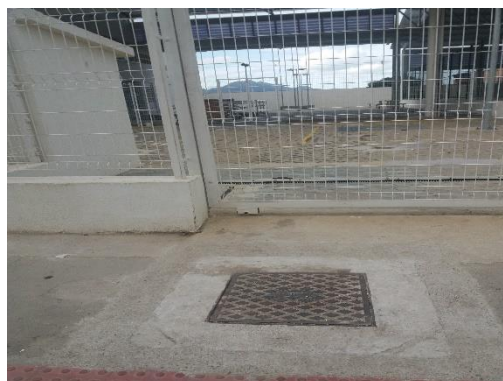
Foto nº 8 – Vista da caixa de saída da rede de esgoto da escola.
