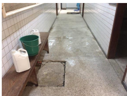
Foto nº 12 – Vista do piso do tipo granilite no pátio interno
